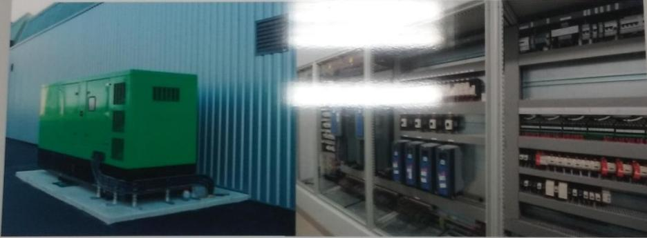
En cas de coupure de courant, le groupe électrogène se met en route automatiquement en quelques secondes et l'usine reprend la production. La distribution d'une eau de qualité est alors maintenue.
