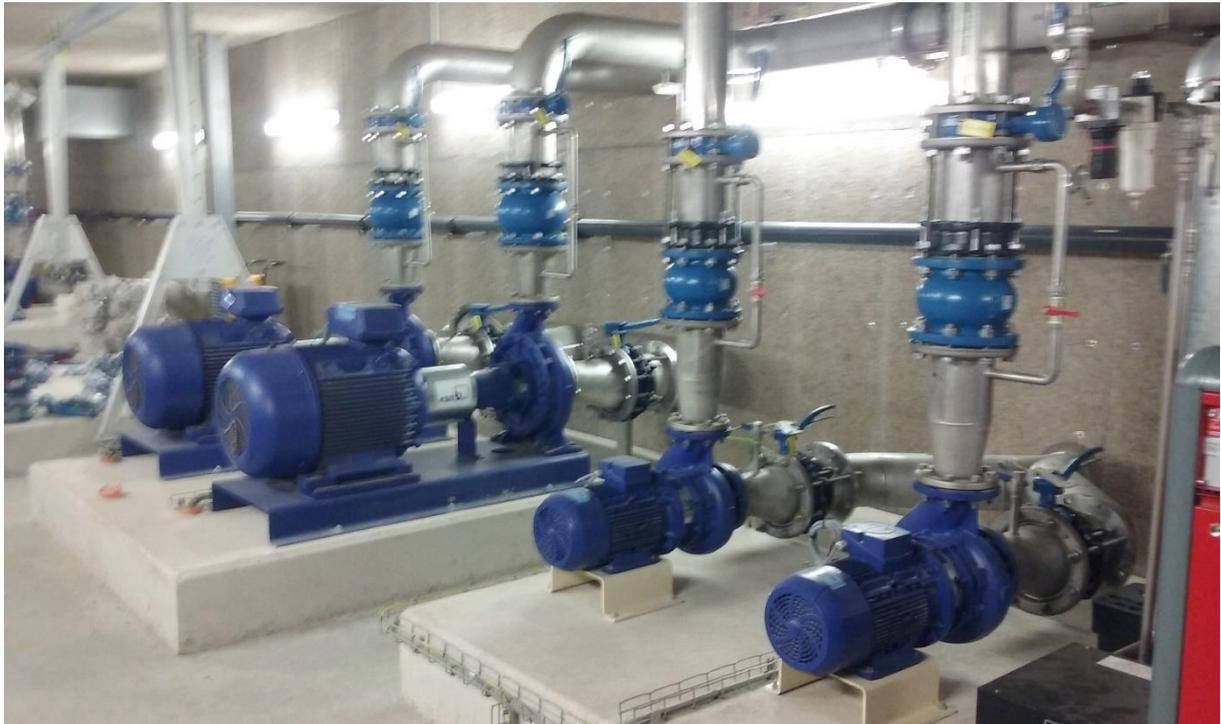
Il existe deux sortes de pompes. Les petites sont utilisées afin d'acheminer l'eau aux différents endroits de l'usine et les grosses jusqu'aux châteaux d'eau.
