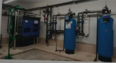
A gauche le coffret de dosage de soude renferme les pompes doseuses afin de protéger les travailleurs de toute projection accidentelle. A droite, la production d'eau adoucie, utilisée pour produire la saumure, diluer la saumure et parfaire le rinçage des résines en fin de régénération.
