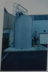
Le silo de sel de 30 tonnes, alimenté avec de l'eau adoucie permet de produire une saumure saturée pour la régénération des résines.
