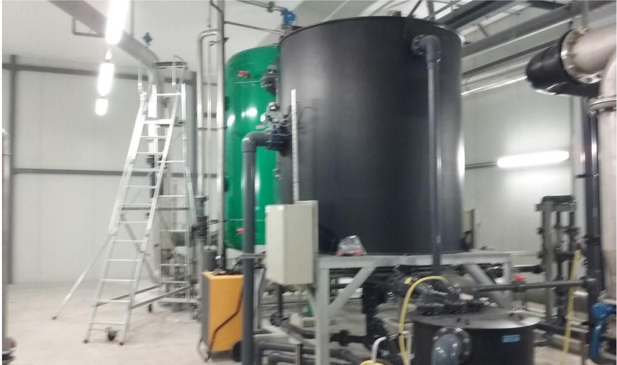
Dans cette cuve, l'eau passe dans une résine afin d'échanger des ions nitrates en ion chlorures.
