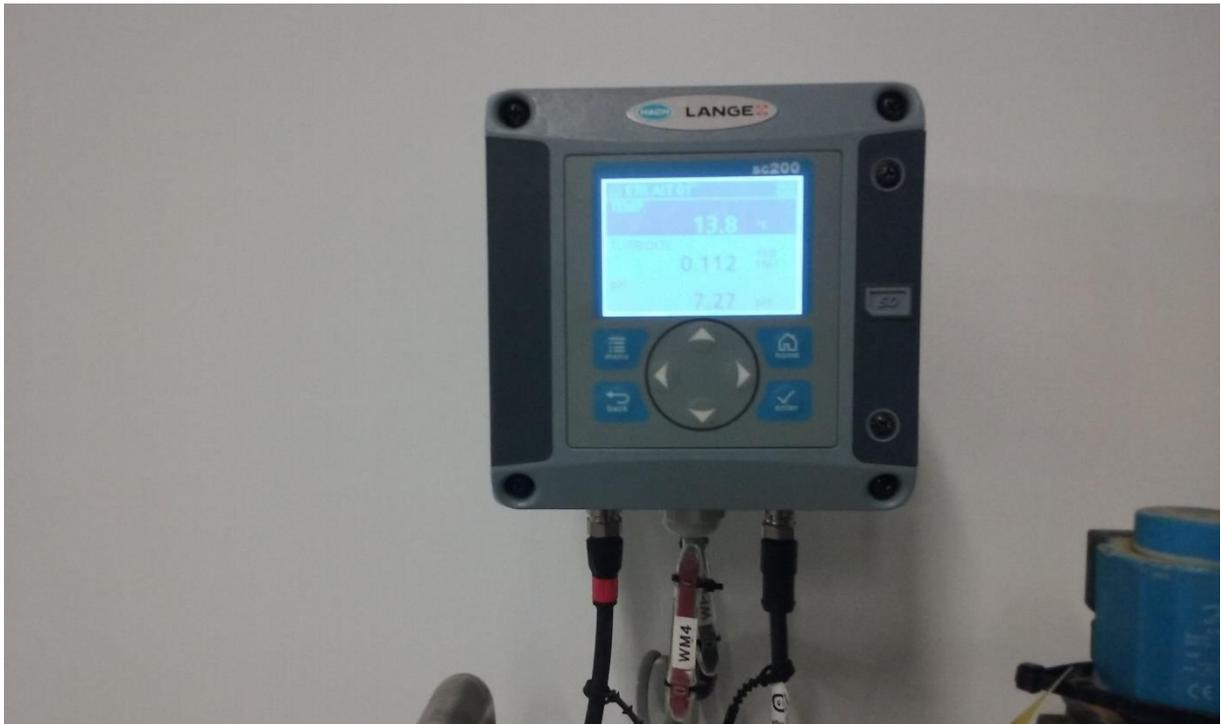
Ce boîtier est connecté à plusieurs sondes qui permettent de mesurer la température, le PH et la turbidité de l'eau.
