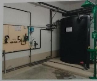
Le dosage de chlore à gauche pour la désinfection résiduelle et la cuve de stockage de saumure à droite.
